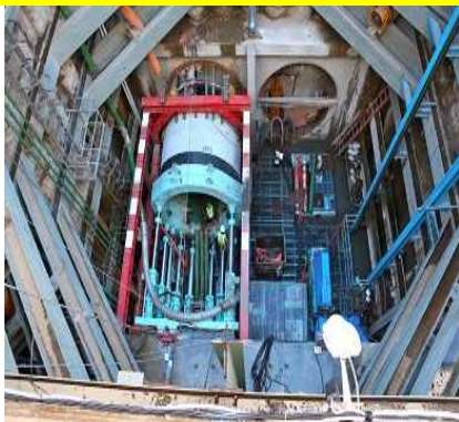
道路を掘り返さずに下水管を新設する 下水道推進工法（写真中央左）
