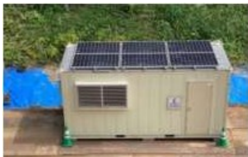
準備工の休憩所設置
