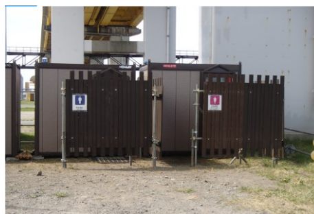
準備工の仮設トイレ設置
