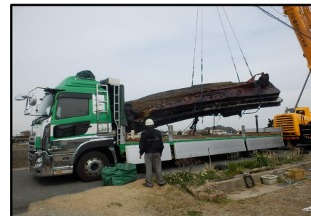
【R3年度撤去工事】
