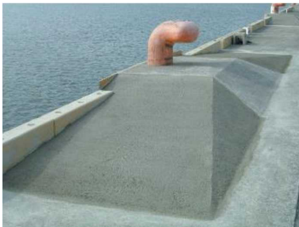
係船柱大型化に伴う上部工嵩上げ事例
