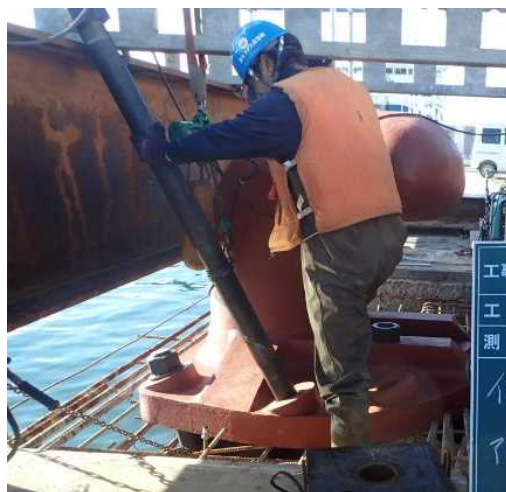
2000kN型(市販型)下部の設置状況
