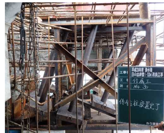
2000kN型(市販型)下部の設置状況
