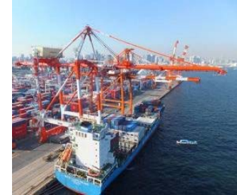
ガントリークレーン
