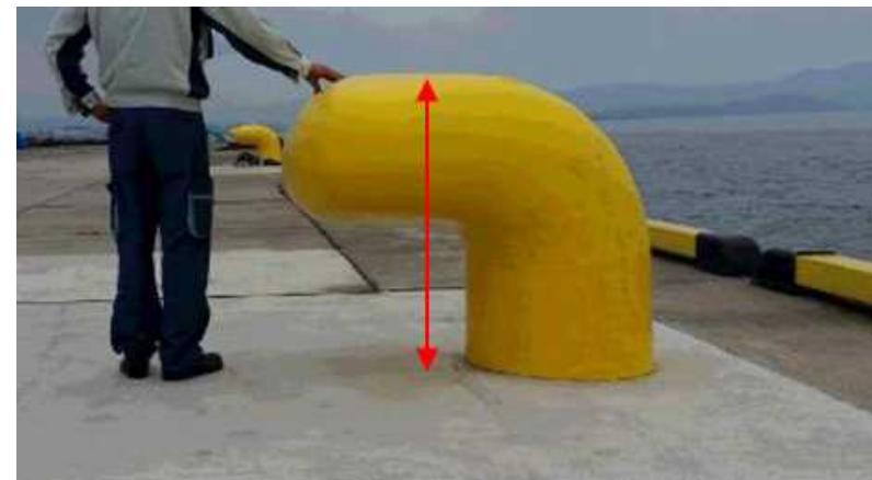
2000kN型の大型係船曲柱 西岡ら,国総研資料No. 957, 係留施設の附帯設備等の整備に おける繫離船作業の安全性向上への配慮事項に関する検討
