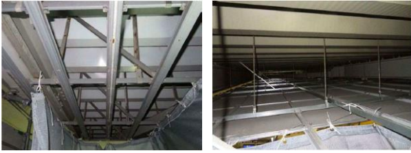
図4 既存天井の様子
