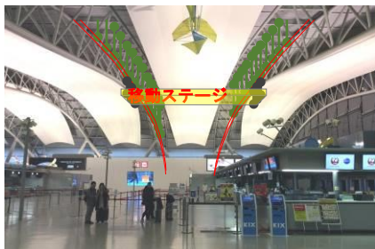
図9 吊り足場設置イメージ
