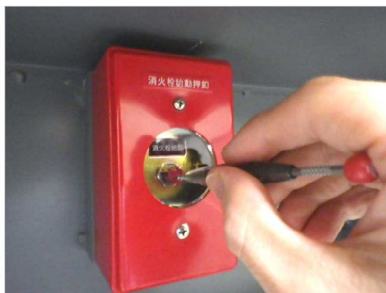
図10 点検方法 (空けた穴からおっぺす棒を挿入)
