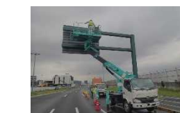
＜道路標識近接目視＞
