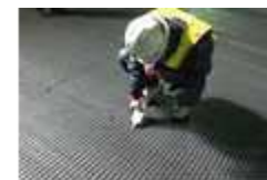
＜ひび割れ注入＞
