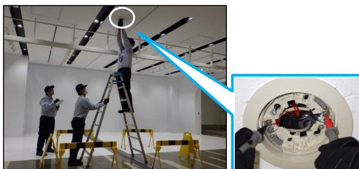
【図5】 従来の電圧測定作業
