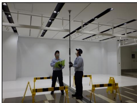
【図6】 着脱棒でのヘッド交換作業
