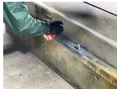
④溶接部清掃、補修
