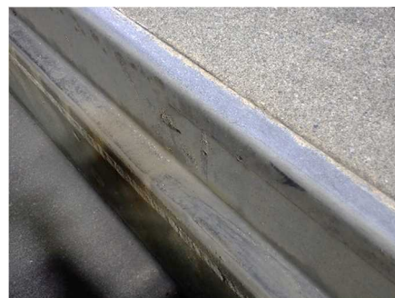
既設受枠状況
