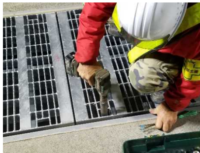
⑤新設蓋設置
