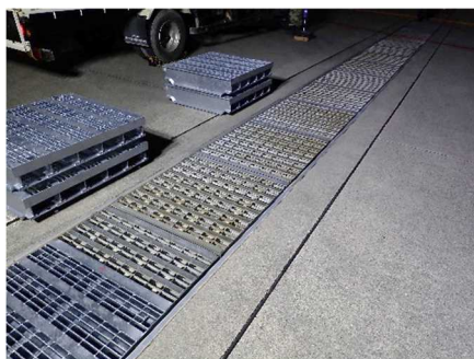
既設グレーティング設置状況
