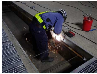
③ボルトピース取付
