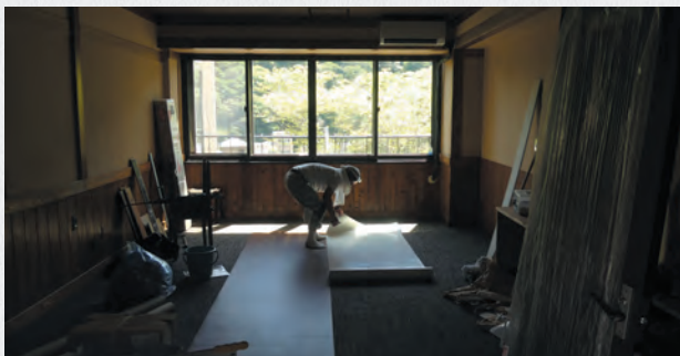
客室改装を行っているのは清掃担当のスタッフ。慣れた手つきでクロスを裁断
