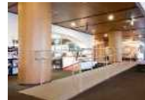
スロープの設置
