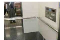
車椅子対応エレベーターの設置
