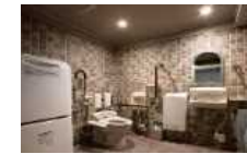
共用トイレのバリアフリー化
