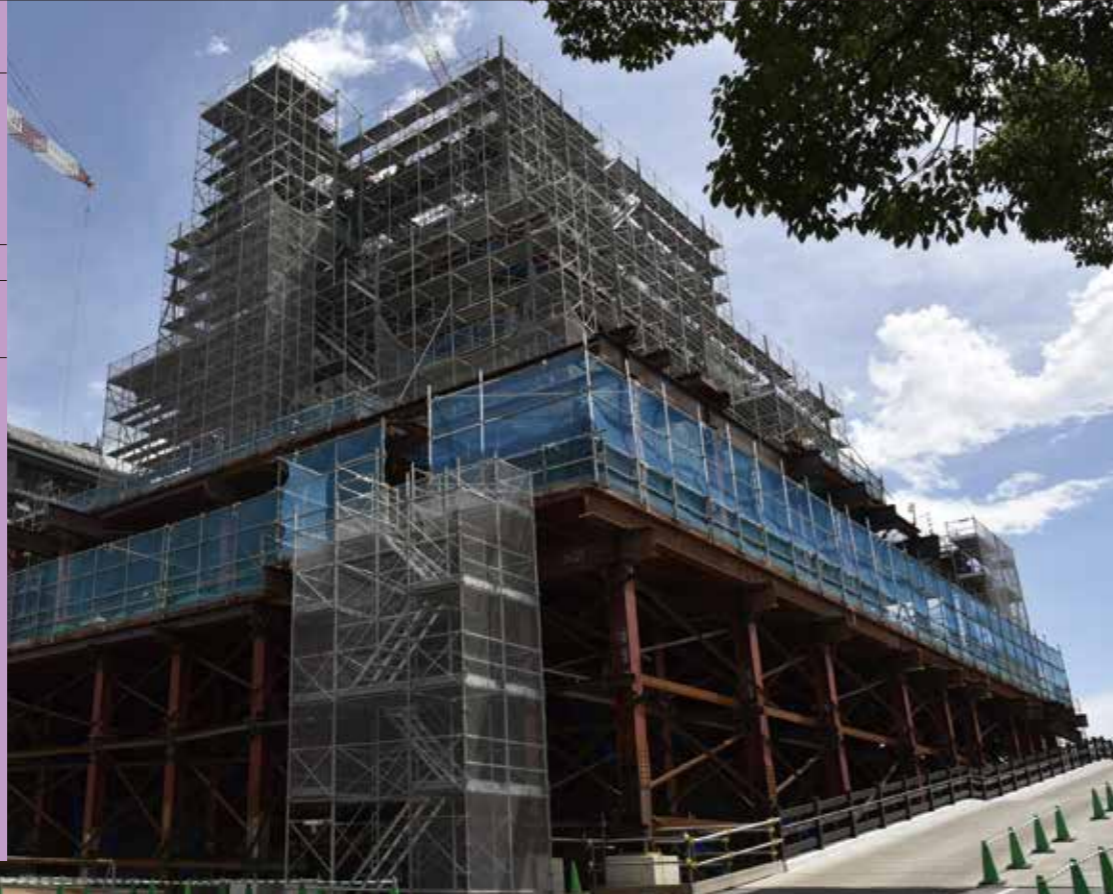
復旧工事が進む熊本城
