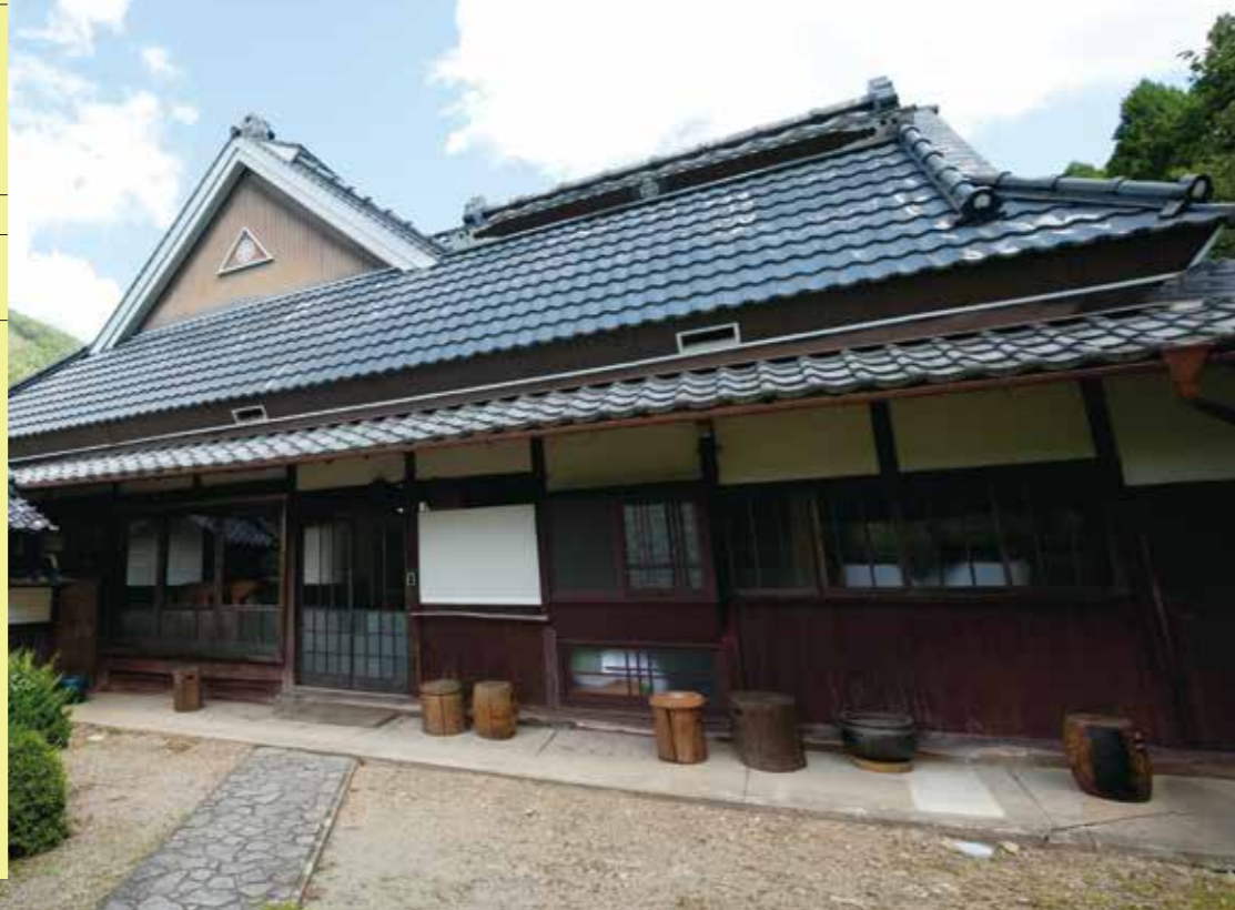
集落丸山宿泊棟「明かり」外観
