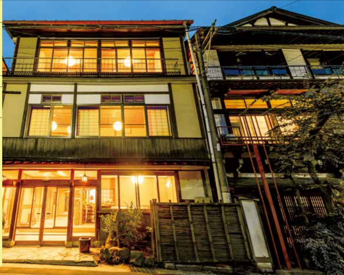
廃業していた老舗旅館を引き継いでホステルに改装
