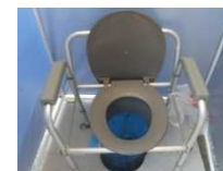
マンホールトイレ
