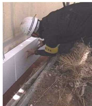
外壁の断熱化工事
