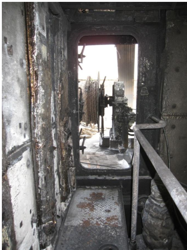
写真2 機関室後部入口（機関室内部からプープデッキを見る）
