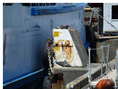
岸壁の防衝設備
