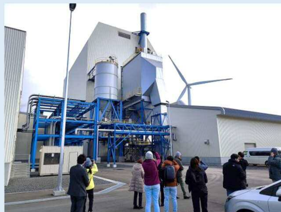
（石狩市 バイオマス発電所と風力発電所）
