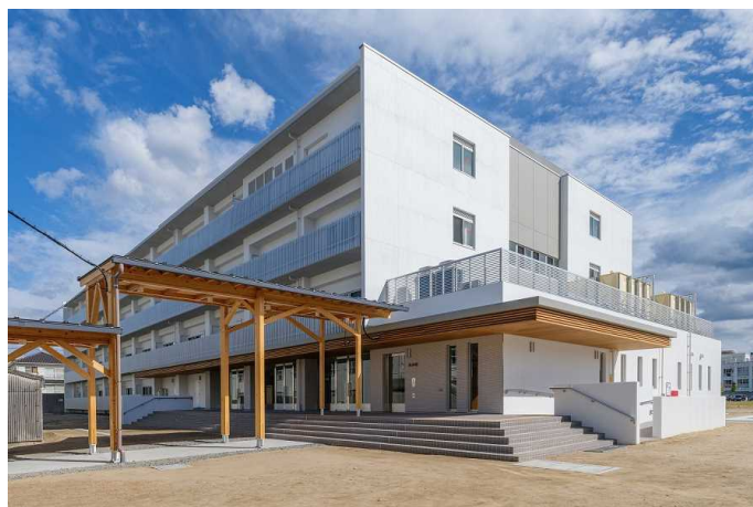
<中国四国管区警察学校（渡り廊下部分）>
