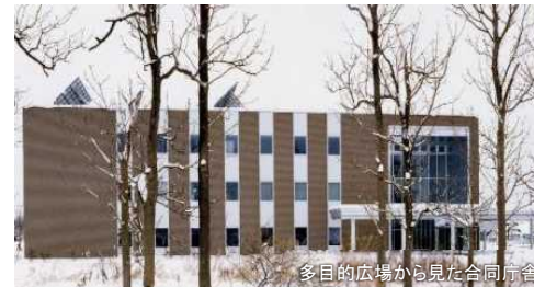
多目的広場から見た合同庁舎
