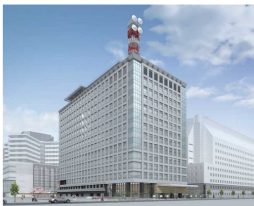
大阪第6地方合同庁舎（仮称） (ZEB Oriented/2022年竣工予定)
