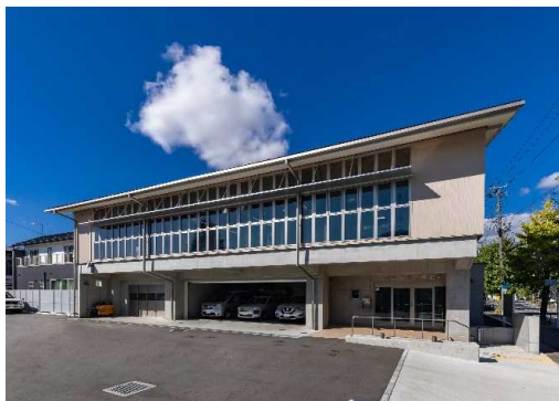
福島県須賀川土木事務所庁舎 (Nearly ZEB/2020年竣工)
