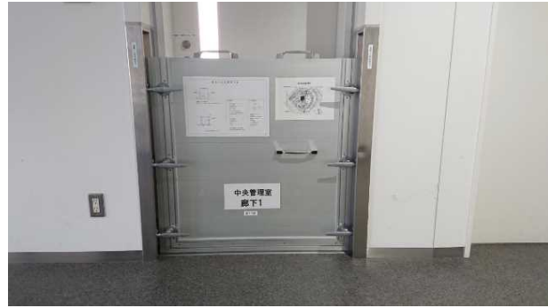
止水板の設置 (東雲地方合同庁舎(東京都))
