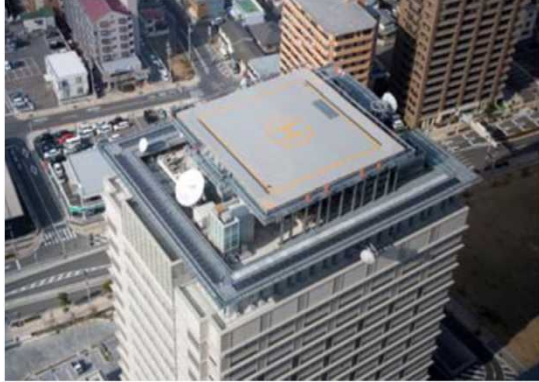
屋上ヘリポート(※)
