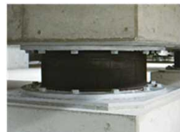
鉛入積層ゴムアイソレータ
