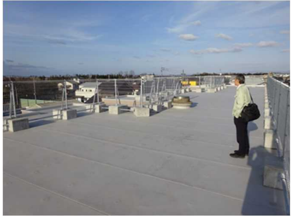
屋上避難スペース
