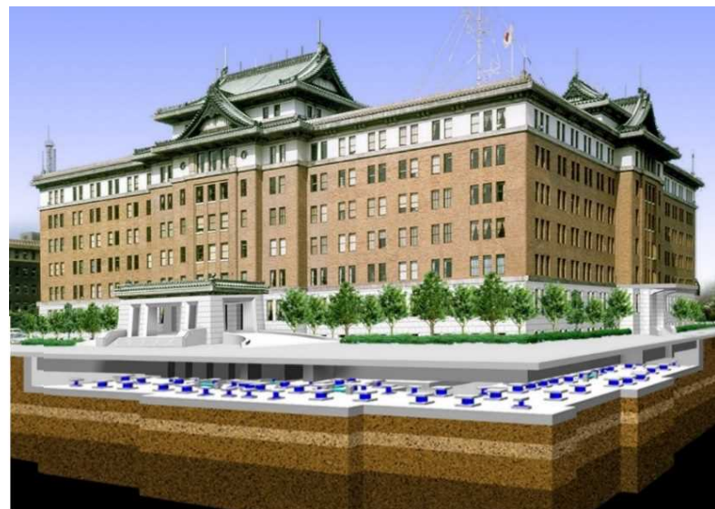
鉛入積層ゴムアイソレータ
