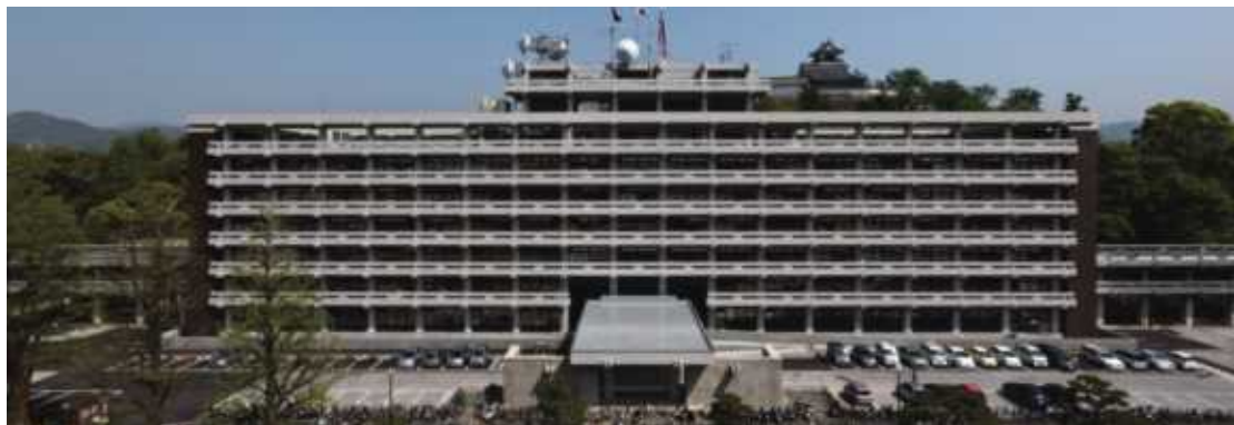
免震レトロフィット工法の採用により高知城を背景とした景観及び建築造形を保存
