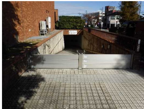
止水板の設置 (金沢新神田地方合同庁舎(石川県))
