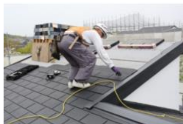
屋根の断熱化工事
