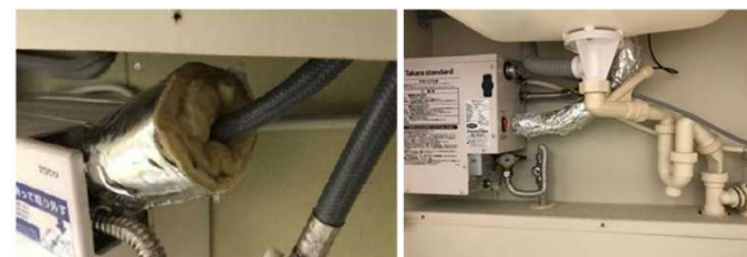
(給湯配管の保温工事)
