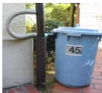
ポリバケツ(45L)を利用 集水継ぎ手と洗濯機用ホース はホームセンターで購入
