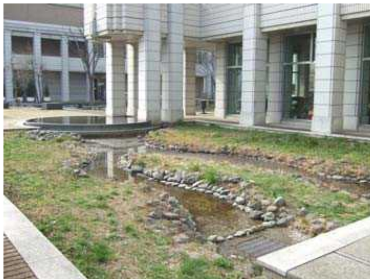
敷地内に降った雨水を、せせらぎに利用（綾瀬市役所）
