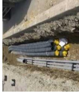
従来よりも浅い位置に管路等を埋設することで、掘削量を減少（H30～R1年度に積雪寒冷地での技術的検証として試験施工を実施）。
