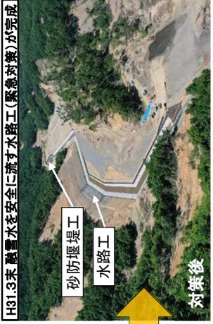
H31.3末 融雪水を安全に流す水路工(緊急対策)が完成
