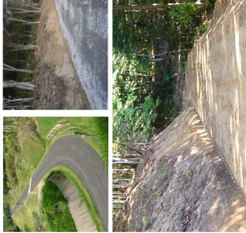
(左) 幹線となり一般車両の走行も想定した「林道」、(右) 10t積み程度のトラックの走行を想定した「林業専用道」、(下) 林業機械の走行を想定した「森林作業道」
