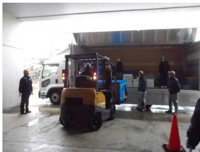
図表Ⅱ-3-11 4 t 車からのフォークリフトによる荷降ろし
