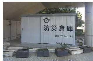
帰宅困難者用備蓄倉庫
