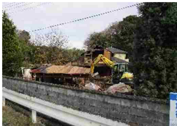
写真2: 屋根が崩壊した空き家(荒尾地区)
