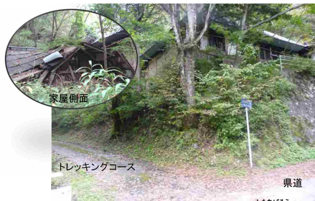
写真1: 道路に隣接する荒廃空き家(下上籠)
