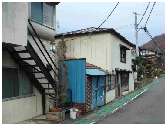
写真1: 中心市街地の空き家(大月地区内) 〈窓の割れ、ベニヤ板での補強等あり〉
