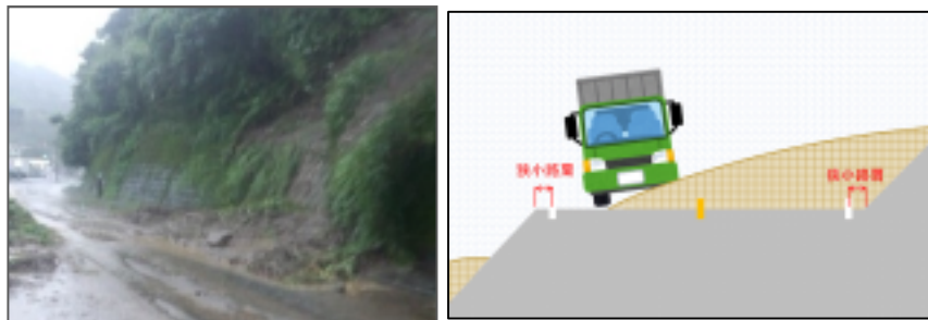
法面崩壊による通行止め
