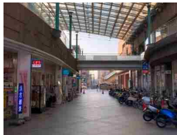
商業（路面店舗部分）
