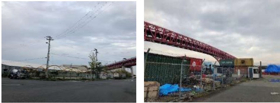
図表 59 第一突堤の上屋（左）及び周辺の状況
