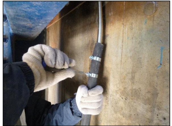
写真—2 桁下設置例
