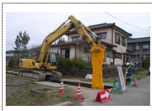
写真三 近接施工事例
