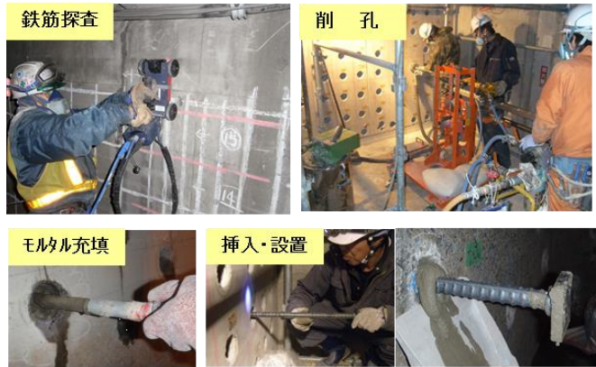
写真-1 施工状況
