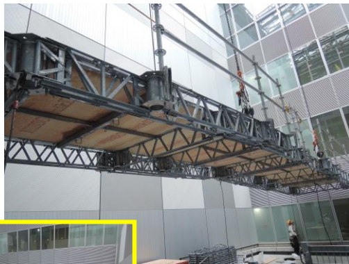
図一 1 クイックデッキ概要図
