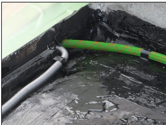
写真—3 JD導水管設置例
