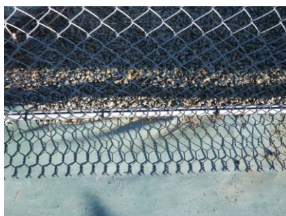
写真-4 設置状況(正面)
