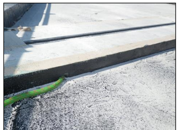
写真—4 JD導水管設置例
