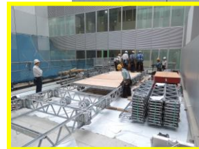
写真一 3 ユニット一括吊上げの様子
