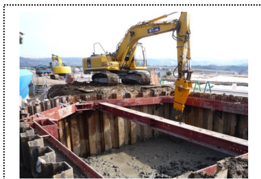
写真四 切梁直下の斜め施工状況
