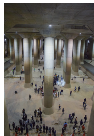
首都圏外郭放水路の見学会状況
