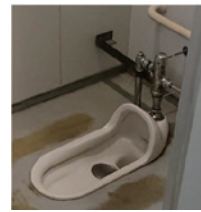
(改修前) 和式便器
