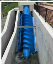
■ 小瀧水力発電所(小瀧井堰地点らせん水車導入実証設備)
