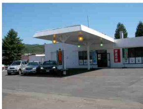
植村建設株式会社 『安全の駅』
