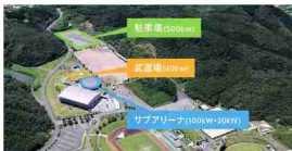
■ 総合運動公園 発電施設
