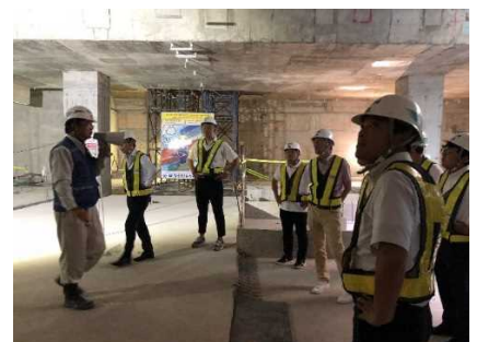
・工事現場視察
