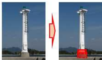
アンカーボルト露出 → コンクリートで保護（環境遮断）
