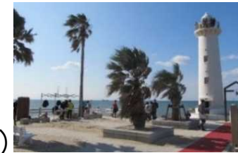
公園・遊歩道整備(野間埼灯台)
