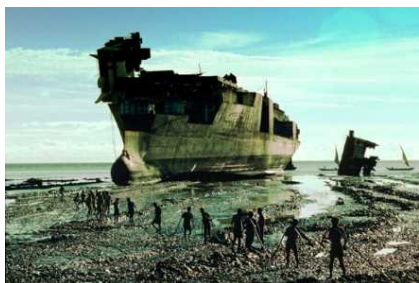
労働安全・環境対策がなされていない途上国の解体施設
