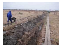
水抜き水路の埋め戻し
