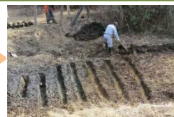
土砂堆積部分の浚渫
