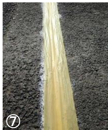
車の通行可能(片栗粉は 水と分離する性質を有し、 降雨に強い)
