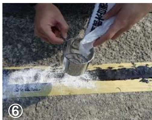
片栗粉を養生に流用 (飛散しても安心) (環境負荷低減効果)
