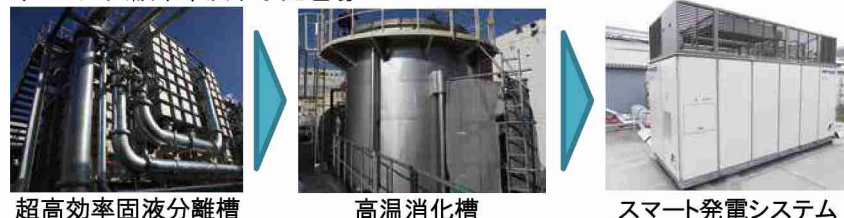
超高効率固液分離槽 高温消化槽 スマート発電システム
