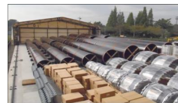
資材の備蓄状況(鋼管、継手補強材、ブルーシート等)
