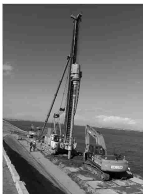
河川堤防における地震・津波対策 (三重県桑名市長島町)
