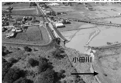
堤防決壊（高梁川水系小田川 左岸 6k400） 岡山県倉敷市真備町
