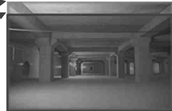
平成 30 年 7 月豪雨における貯留状況
