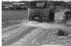
散水車による防塵対策 【岡山県倉敷市真備町】
