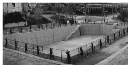
小規模な雨水貯留浸透施設の例
