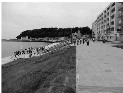
石巻市中央地区再開発事業及び 河川堤防の整備状況（平成 30 年 6 月）
