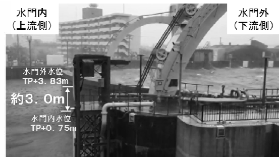
台風第21号による高波来襲から市街地を守る木津川水門（平成30年9月4日）
