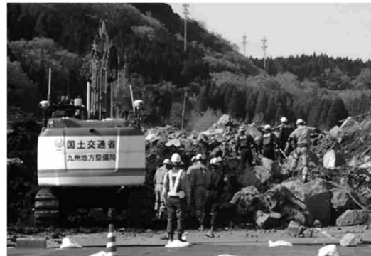
遠隔操縦式バックホウにより、安全を確保しながら 捜索活動を支援 【平成28年熊本地震：南阿蘇村】
