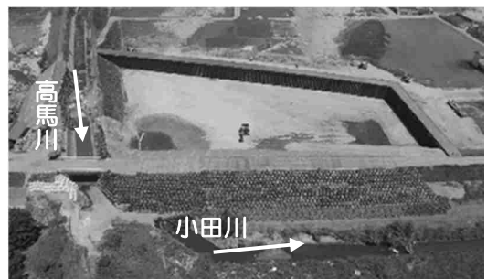
堤防復旧状況（7/21 10:00 時点）左岸 3k400 【高梁川水系小田川】
