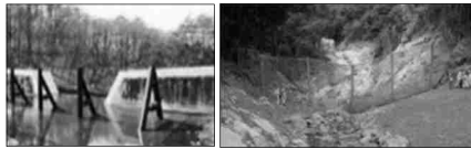
・後付式の流木捕捉工や強靱ワイヤーネットを活用した緊急整備
