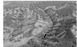
東和川周辺の山腹崩壊 (北海道厚真町)
