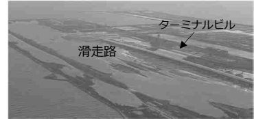
関西国際空港の浸水状況
