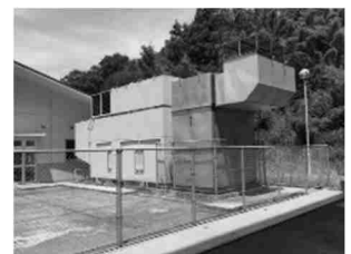
②高所等の点検
