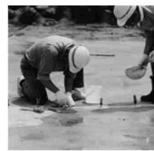
クラック補修状況 (注工)
