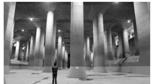
首都圏外郭放水路（埼玉県）
