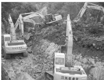
無人化施工の高度化例
