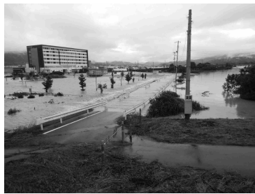
ひじがわ 肱川沿川の被災状況（ あまみ 愛媛県大洲市）
