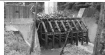
透過型砂防堰堤
