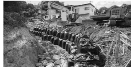
応急対策工事（流路確保）の実施 （広島県広島市）
