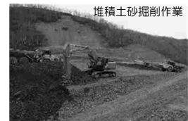
日高幌内川の河道閉塞への対応状況 (北海道厚真町幌内地区)
