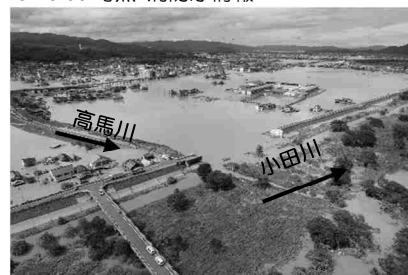
堤防決壊（高梁川水系小田川 左岸 3k400） 岡山県倉敷市真備町
