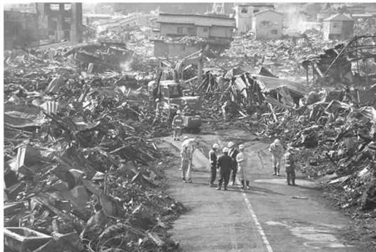
道路啓開により津波による被災地の救命・救助 ルートを確認 【東日本大震災：宮城県気仙沼市】
