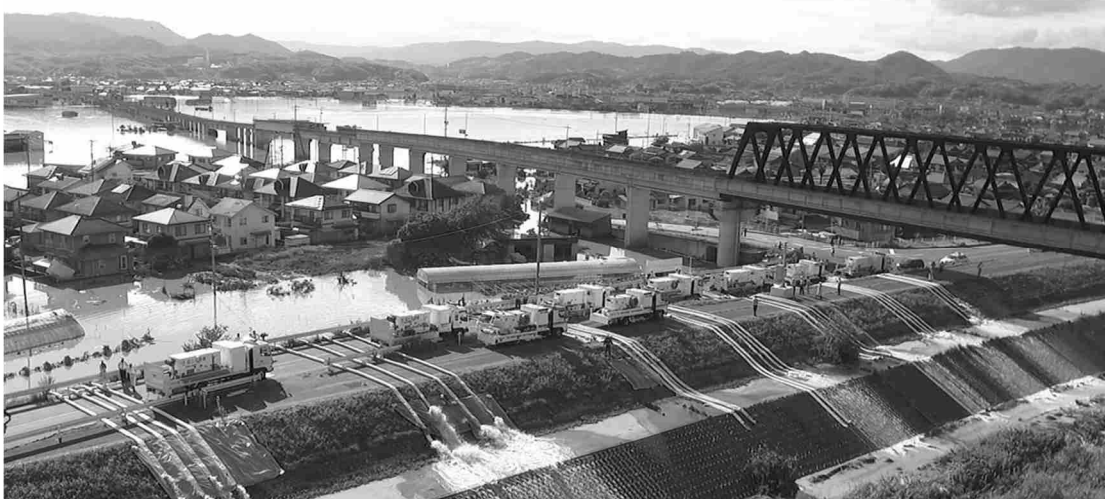
昼夜を問わず排水作業を実施し、約1,200haの浸水を3日間で概ね解消 【平成30年7月豪雨：岡山県倉敷市真備町】
