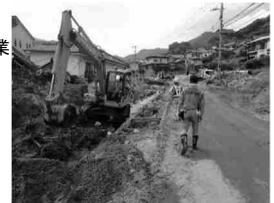
市街地の土砂等の 撤去作業 【広島県安芸郡坂町】
