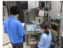
(航空保安施設点検実施状況)
