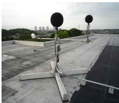
騒音測定局（屋上設置時）
