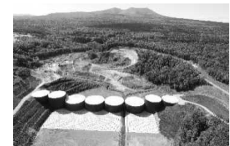
樽前山覚生川2号砂防堰堤（苫小牧市）
