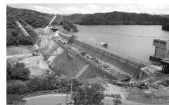
工事中の新桂沢ダム（三笠市）
