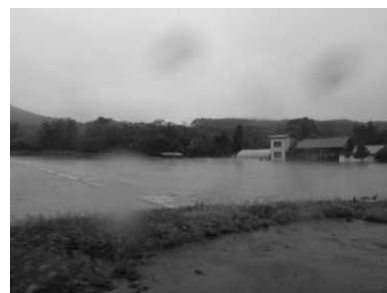
ペーパン川の浸水状況（旭川市）
