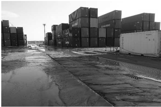
苫小牧港の液状化状況
