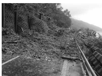
国道453号斜面崩壊・応急復旧状況（千歳市）
