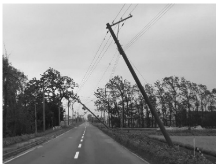
平成30年台風第21号による電柱倒壊
