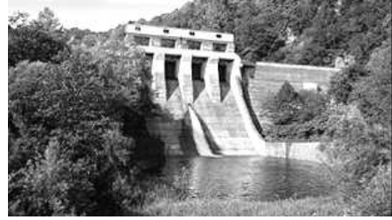
かさ上げ予定の雨竜第2ダム
