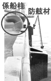
大型クルーズ船に対応した係船柱※1・防舷材※2の設置
