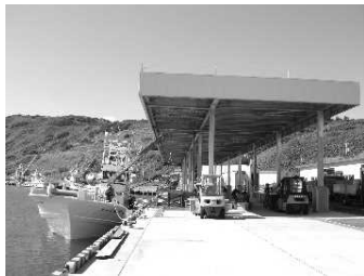
【高度衛生管理対策：屋根付き岸壁、清浄海水導入施設】
