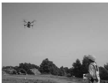
UAV(ドローン)等を活用した3次元測量
