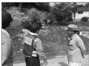
地域住民からの被災状況確認 （広島県三原市）
