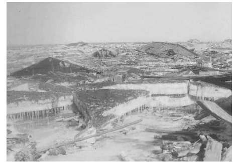
流氷等により破壊された家屋 (1952年 十勝沖地震) 出典：浜中町役場
