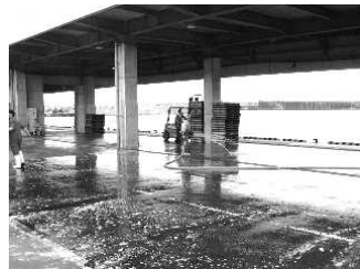
【高度衛生管理対策：屋根付き岸壁、清浄海水導入施設】
