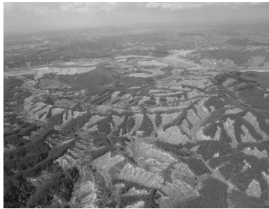
厚真川流域斜面崩落状況
