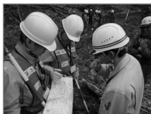
土砂災害危険箇所の点検 （安平町）
