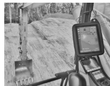
ICT建設機械による施工
