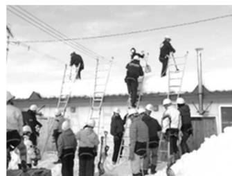
雪下ろし実技講習
