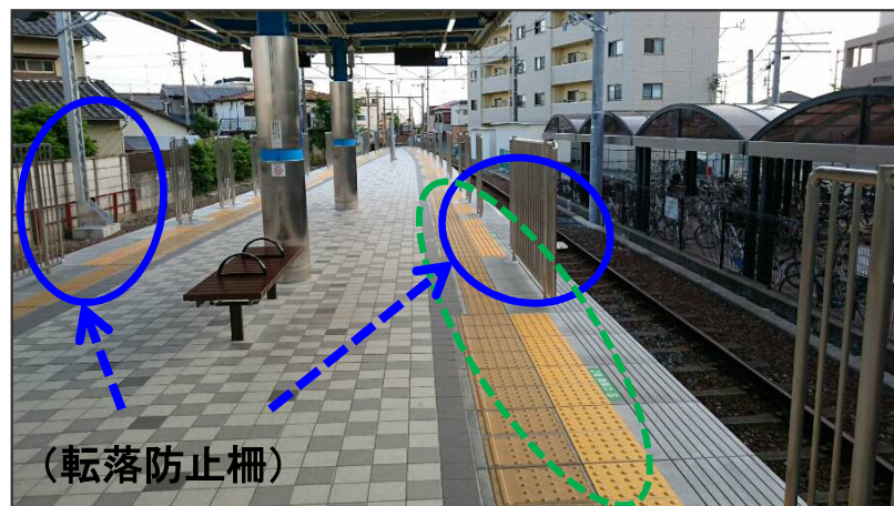
(転落防止柵) (スロープ設置・ホーム幅拡幅) (点状ブロック)
